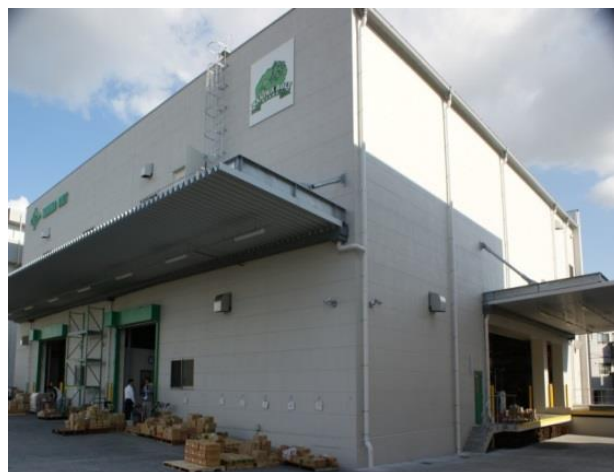
物流倉庫(社屋東面)
